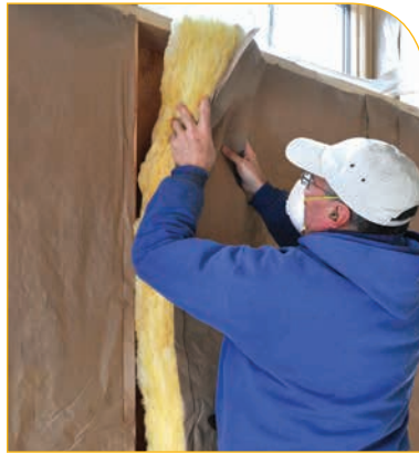
Görsel 5.12: Yalıtım uygulaması
