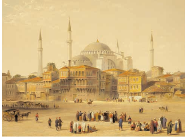
Görsel 7.4 İstanbul'da bulunan Ayasofya Camii (Gravür)
