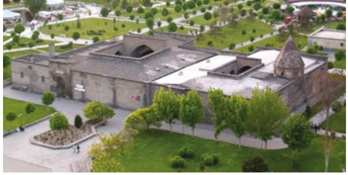
Görsel 4.50 Gevher Nesibe Darüşşifası ve Gıyasiye Medresesi (Kayseri)
