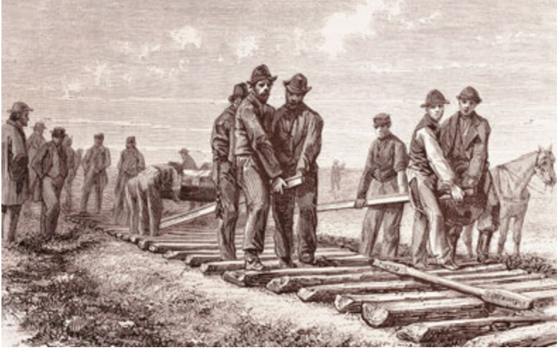
Görsel 5.14 Demiryolu yapımı (Gravür)
