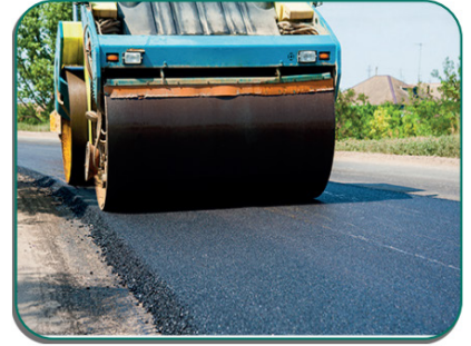
Görsel 3: Asfalt üzerinde hareket eden iş makinesi silindiri: .....
